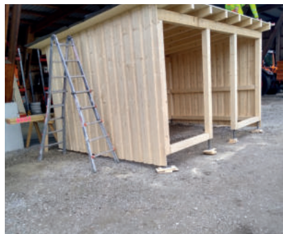
Tauschhütte im Rohbau (auf dem Bauhofgelände)
