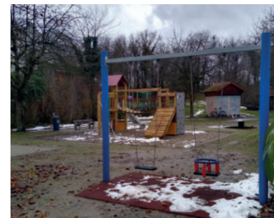
Komplettsanierung Spielplatz nördl. Kleisstr.
