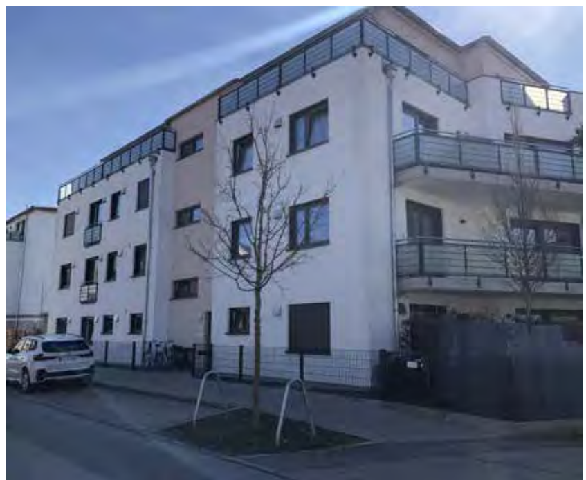
Massive Nachverdichtung im unbeplanten Innenbereich an der Bahnhofstraße
