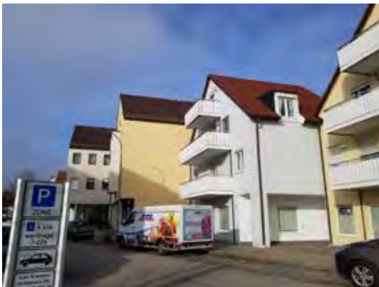
Verdichtungen in der Bahnhofstraße
